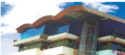
▲ Linkway Indl Est. Roof Covering, Malad
